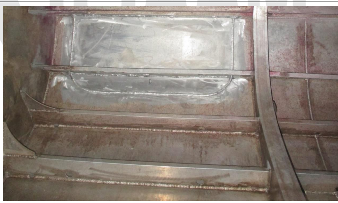
Figura 12: Reparação da fissura no casco, no exterior do fundo do Tanque de Gasóleo de EB. Foto: CV-INTERILHAS.
